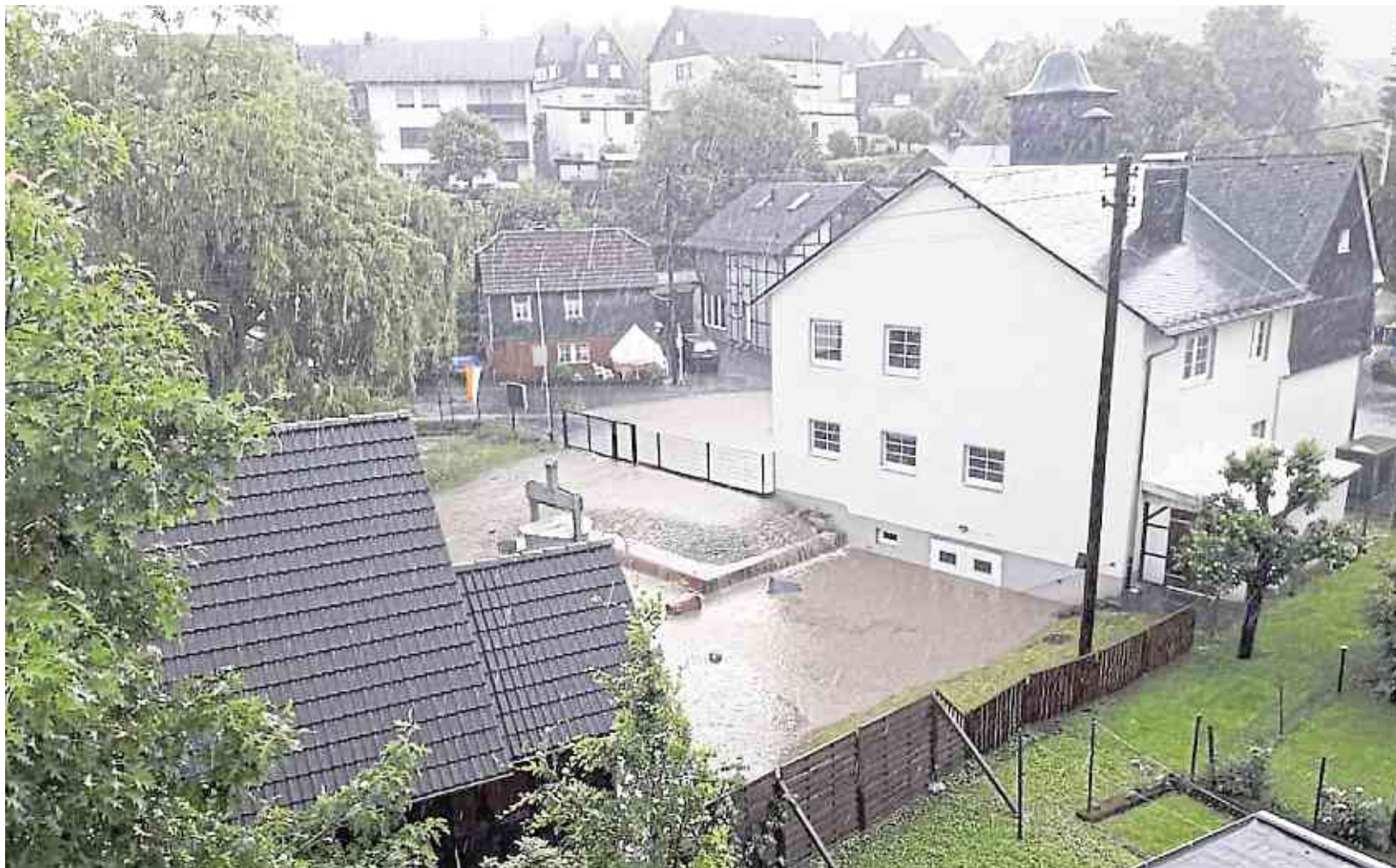
Das Foto vom 31. Mai, dem Tag des enormen Sturzregens, zeigt, wie hoch das Wasser vor der Kellertüre des Kirchener Heimatmuseums stand – und entsprechend hoch auch in den Räumen des Museums dahinter.
